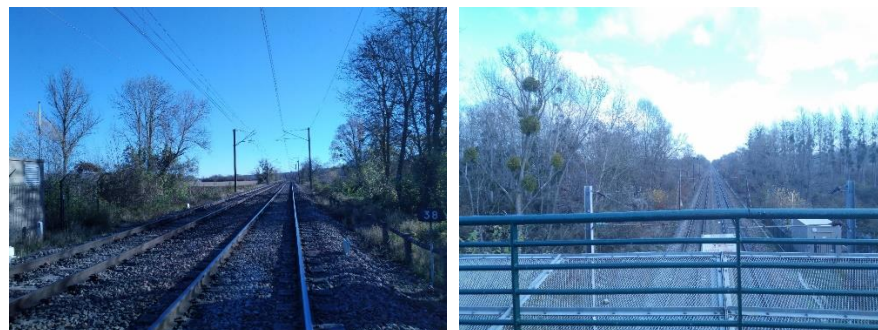
Voie ferrée, support de continuités écologiques – Source : © Ecovia
