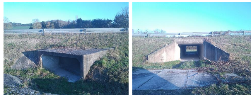
Passages à faune sur le secteur au niveau de la RD9 – Source : © Ecovia
